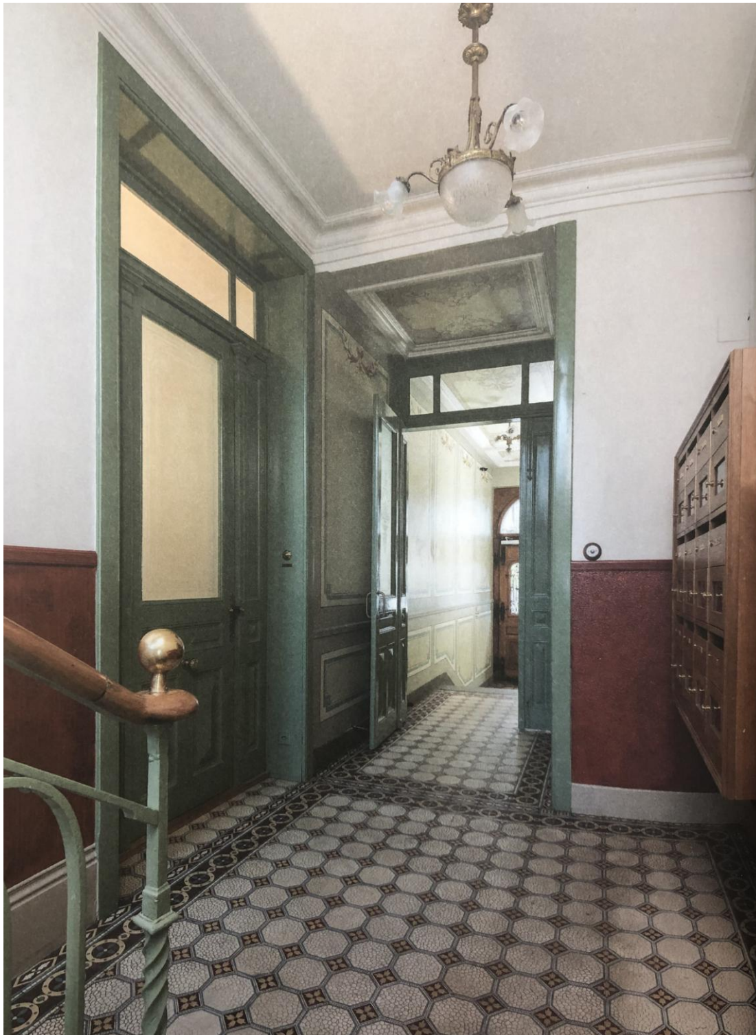
Treppenhalle im Erdgeschoss mit Blick zu den Briefkästen
