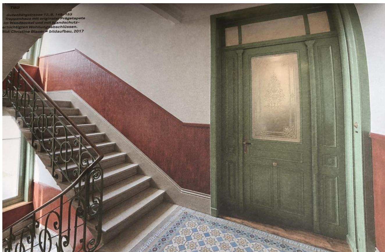
Treppenhaus mit originaler Prägetapete im Wandsockel
